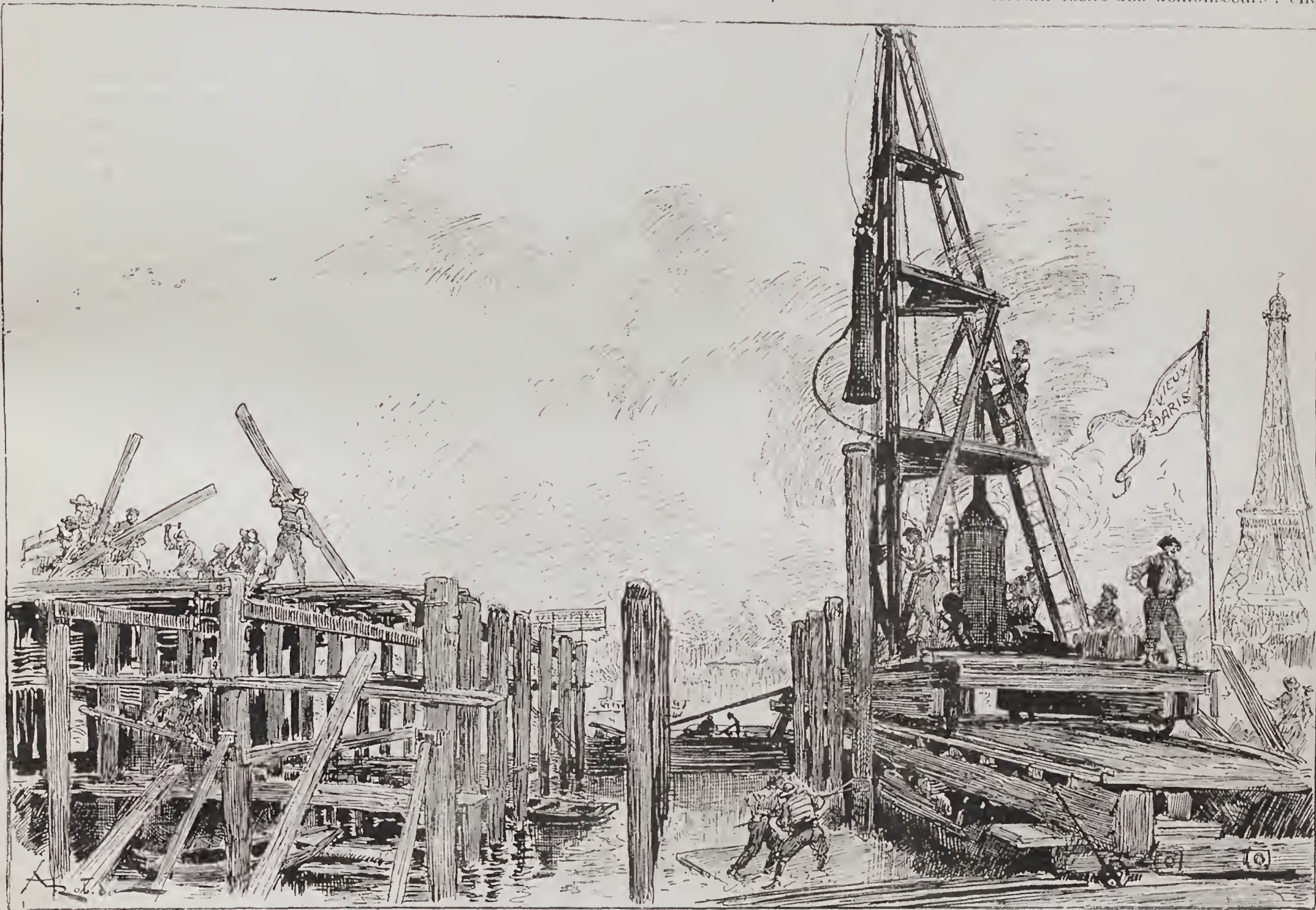
LES TRAVAUX EN SEINE DU « VIEUX PARIS ». — Le battage des pilotis.
